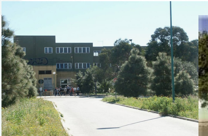
Sede di via Cabras a Monserrato
